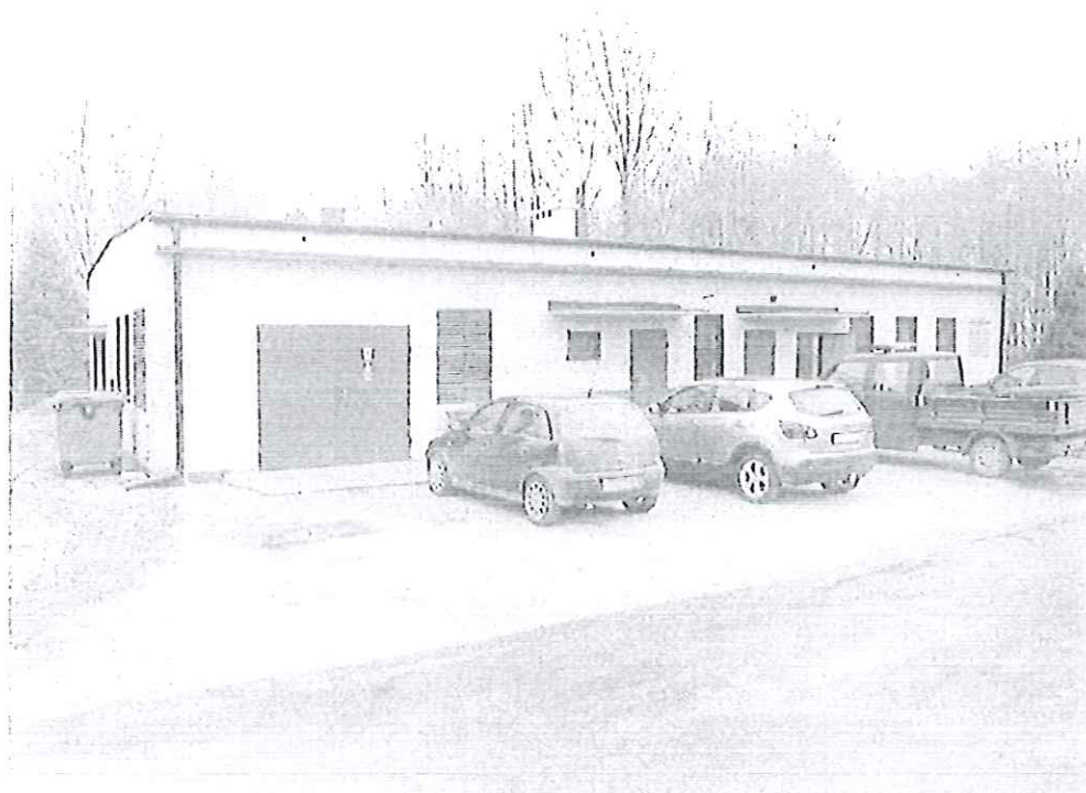
Zdjęcia nr 1. Elewacja frontowa – stan istniejący.
