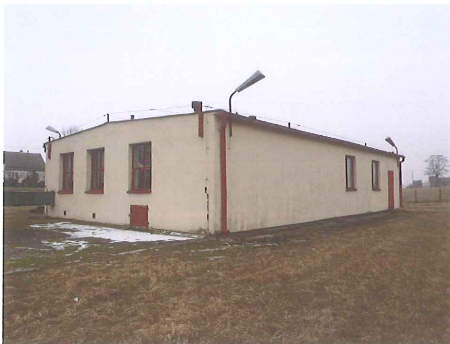
Zdjęcia nr 2. Elewacja boczna – stan istniejący.
