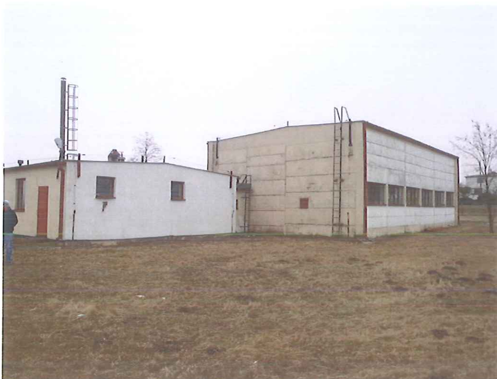
Zdjęcia nr 3. Elewacja tylna – stan istniejący.
