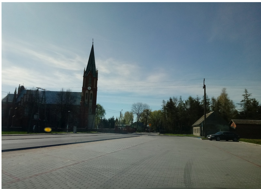
Fot. parking przy drodze powiatowej nr 2105C w m. Wielka Łąka
