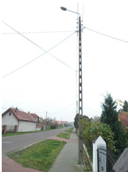
Fot. 1 – przykład słupa napowietrznego z zamontowaną oprawą oświetleniową w mieście Kowalewo Pomorskie
