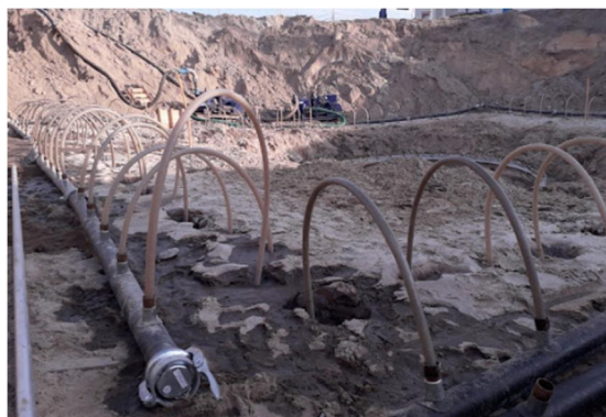
Schemat działania igłofiltrów
