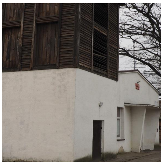
Zdjęcie 1. Remizo-świetlica w Chełmońcu i teren wokół
