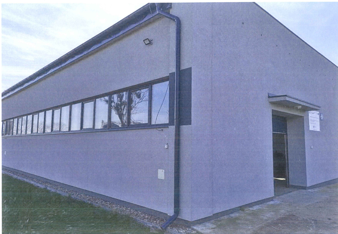
Zdjęcie nr 1 Elewacja frontowa
