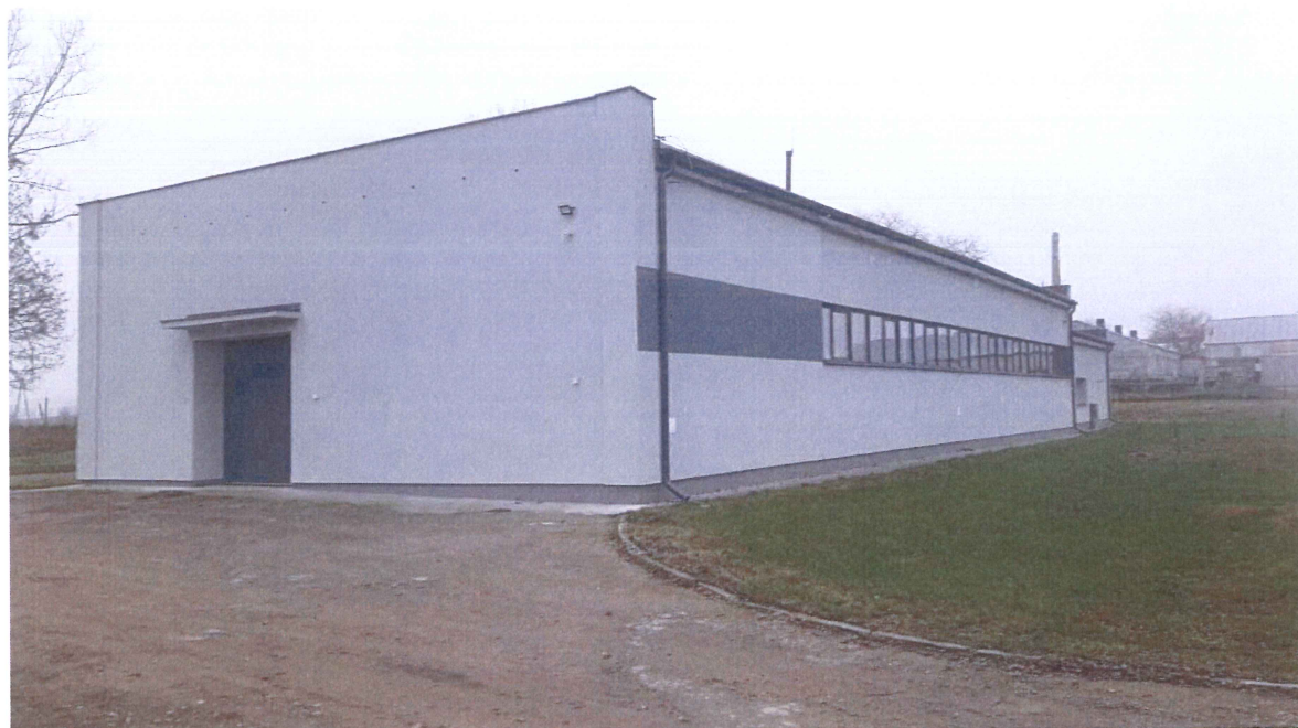
Zdjęcie nr Elewacja tylna i boczna- stan istniejący
