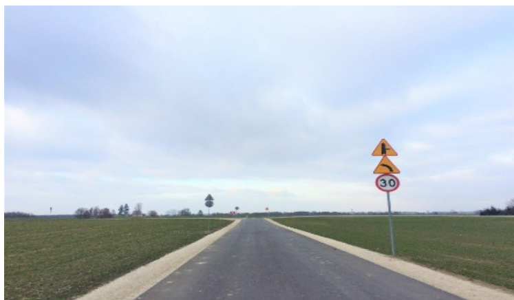
Fot. 13: Przebudowa drogi gminnej Mlewo - Mlewiec
