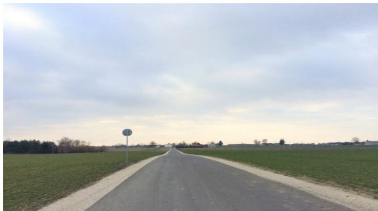
Fot. 14: Przebudowa drogi gminnej Mlewo - Mlewiec
