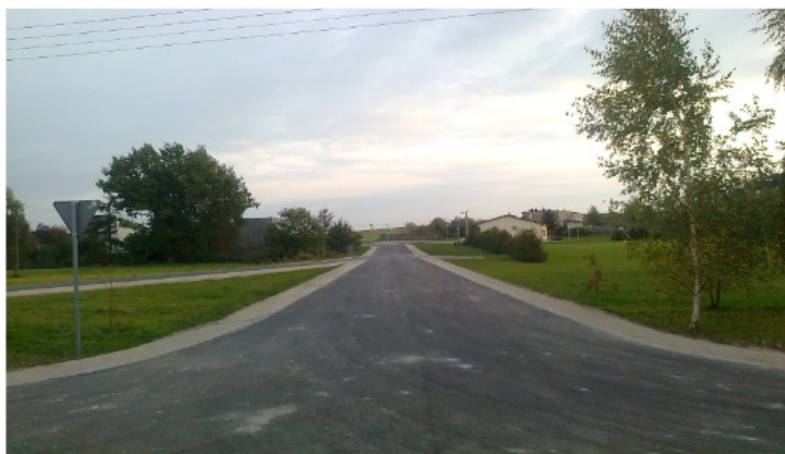
Fot. 15: Przebudowa drogi gminnej w Piątkowie przy świetlicy
