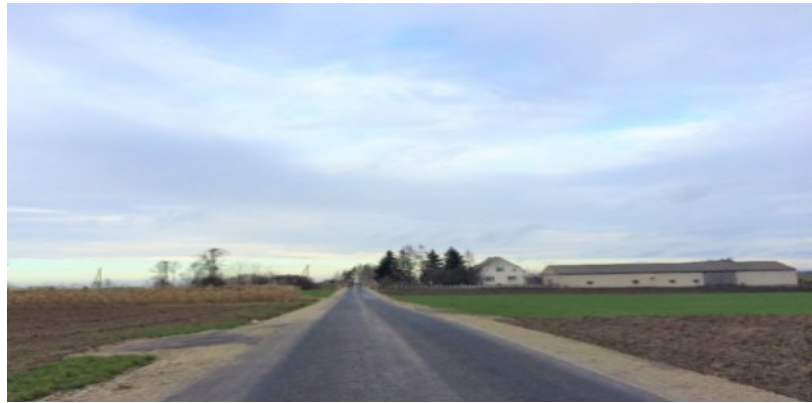
Fot. 12: Przebudowa drogi gminnej Srebrniki - Mariany
