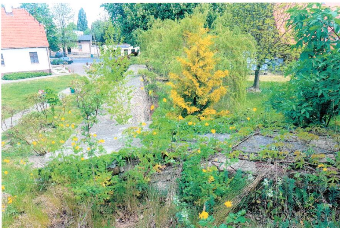
Fot. 46. Fragment muru przedzamcza południowego, stan zachowania korony muru odcinka od strony ul. św. Mikołaja, widoczne spękania cementowego zabezpieczenia korony porośniętej gęsto roślinnością
