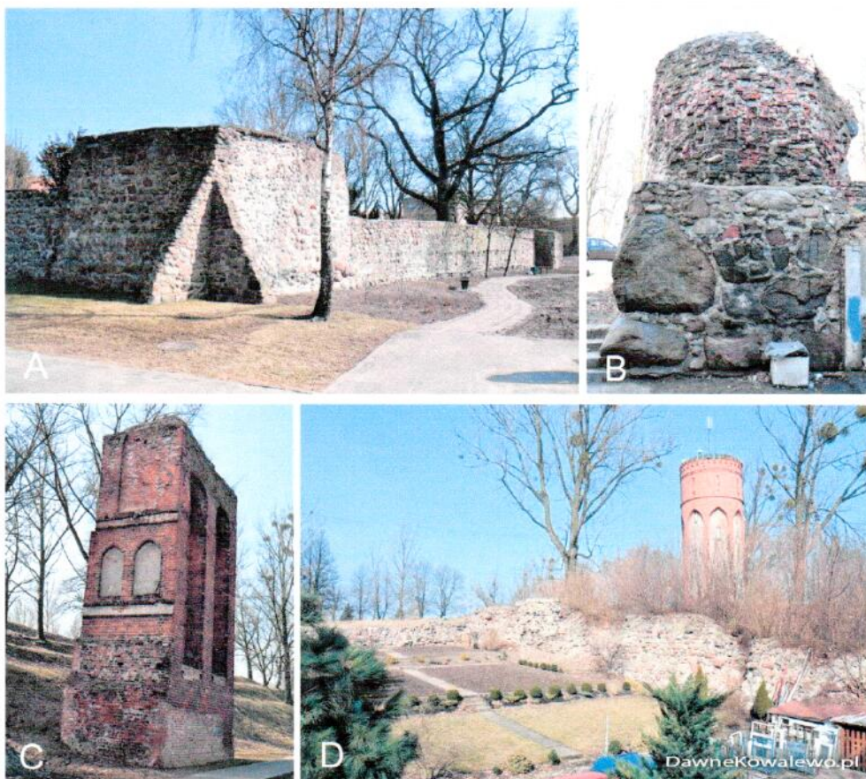
Fot. 3. Kowalewo Pomorskie. Pozostałości zamku: A – mury i baszty przedzamcza południowego, B – baszta przedzamcza środkowego, C – filar gdaniska, D – mur parchamu i fosa (fot. B. Wasik) 6
