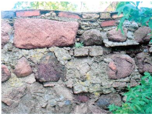
Fot. 28. Lica murów przedzamcza południowego z widocznym odspojeniem napraw korony wykonanych z zapraw cementowych, których spękania umożliwiają penetrację wód opadowych w strukturze muru
