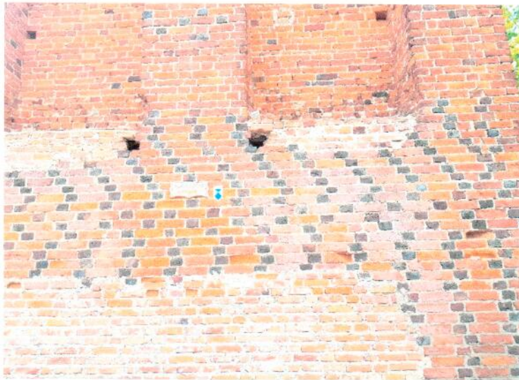
Fot. 10. Fragment ściany gdaniska, widoczne naprawy i uzupełnienia murów
