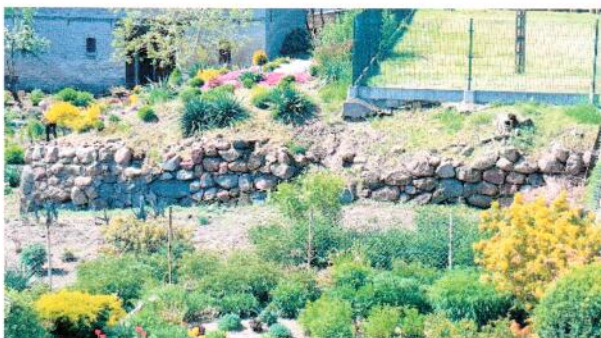
Fot. 15. Mur przedzamcza środkowego, fragment wschodni i pozostałość dawnej fosy, widok od strony wschodniej
