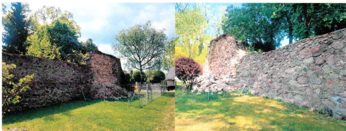
Fot. 6. Fragment murów przedzamcza południowego, odcinek północno-zachodni (stan obecny)
