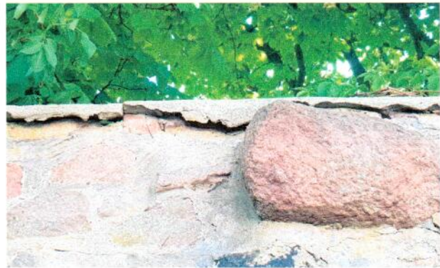
Fot. 28. Lica murów przedzamcza południowego z widocznym odspojeniem napraw korony wykonanych z zapraw cementowych, których spękania umożliwiają penetrację wód opadowych w strukturze muru
