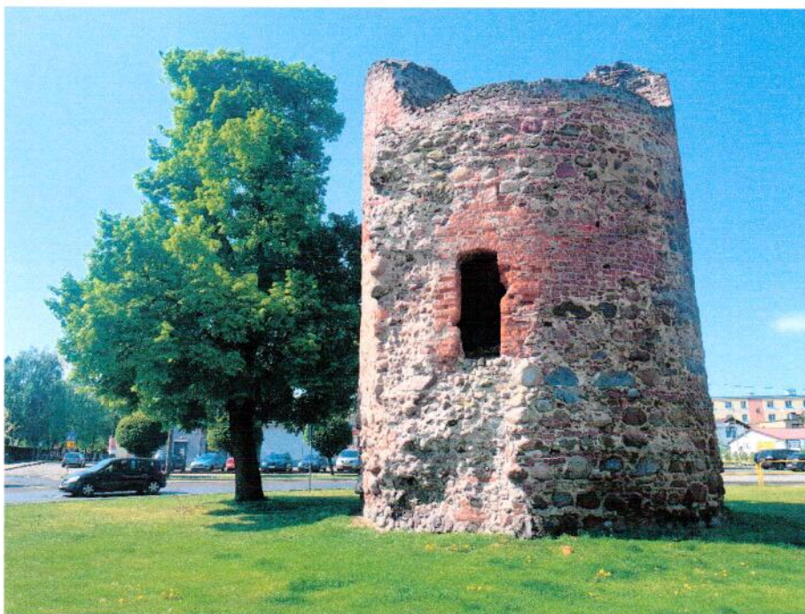
Fot. 4. Baszta – element obramowań miejskich w Kowalewie Pomorskim – obecnie wolnostojąca, widok od północy, od strony parkingu na północ od ul. Batalionów Chłopskich. Jedyne zachowane fragmenty murów miejskich, pozostałość narożnika południowego obwarowań (stan obecny)
