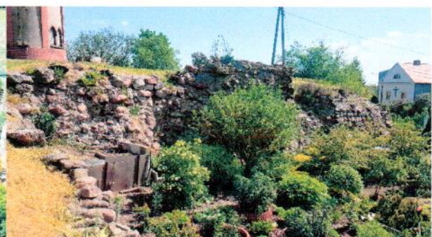
Fot. 16. Mur parchanu zamkowego i pozostałość dawnej fosy, widok od strony południowo-zachodniej
