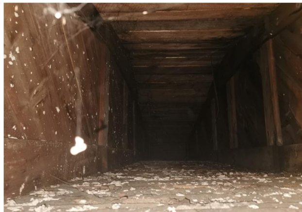
Przestrzeń wewn. dachu
