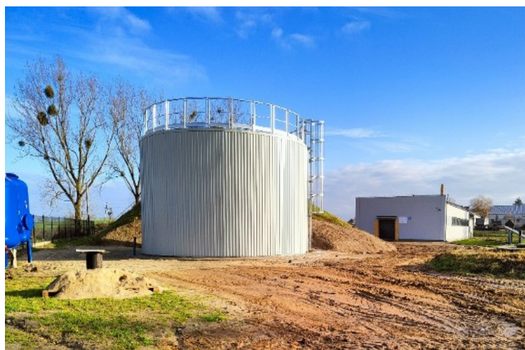
Fot. 19: Przebudowa SUW w Piątkowie
