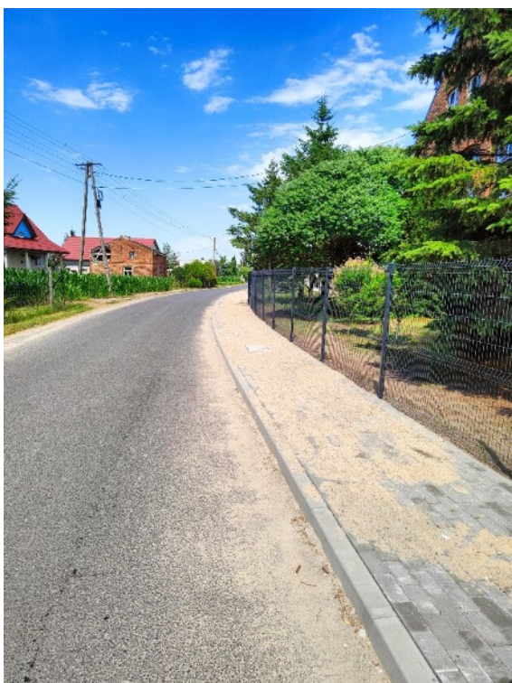
Fot. 15: Wybudowany chodnik w miejscowości Mlewo
