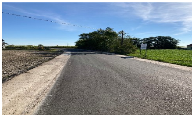
Fot. 13: Przebudowa drogi gminnej Szychowo - Elzanowo
