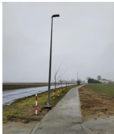
Fot. 23: Zrealizowana inwestycja pn. Budowa linii elektroenergetycznej kablowej do zasilania istniejących opraw LED w m. Sierakowo
