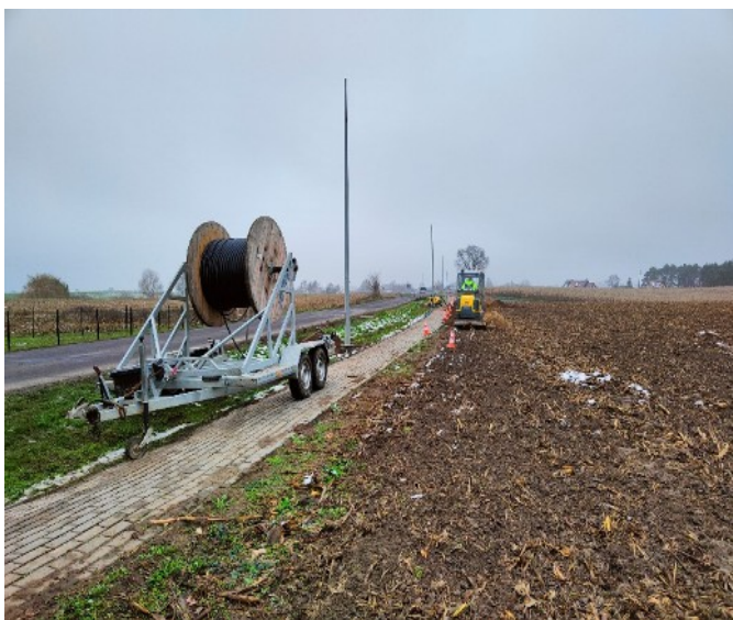
Fot. 22: Prowadzone prace podczas realizacji inwestycji pn. Budowa linii elektroenergetycznej kablowej do zasilania istniejących opraw LED w m. Sierakowo
