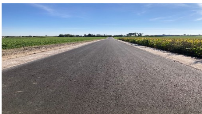
Fot. 14: Przebudowa drogi gminnej Szychowo - Elzanowo
