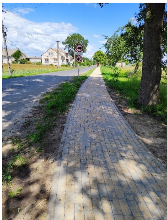
Fot. 16: Wybudowany chodnik w miejscowości Mlewo
