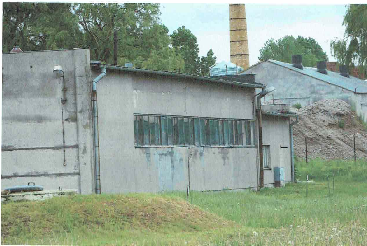
Fot. 4. Ogólny widok elewacji budynku.
