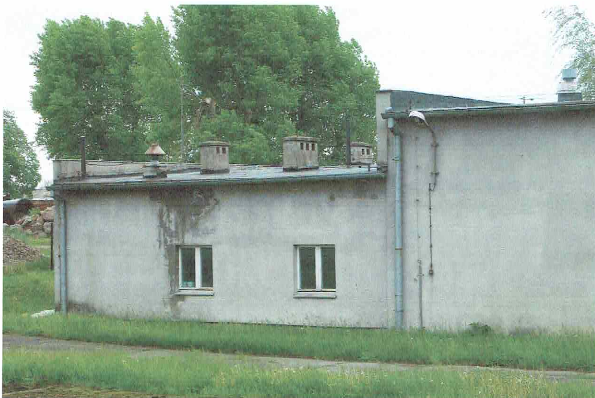
Fot. 3. Ogólny widok elewacji budynku.
