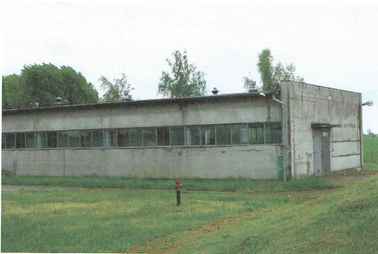
Fot. 2. Ogólny widok elewacji budynku.
