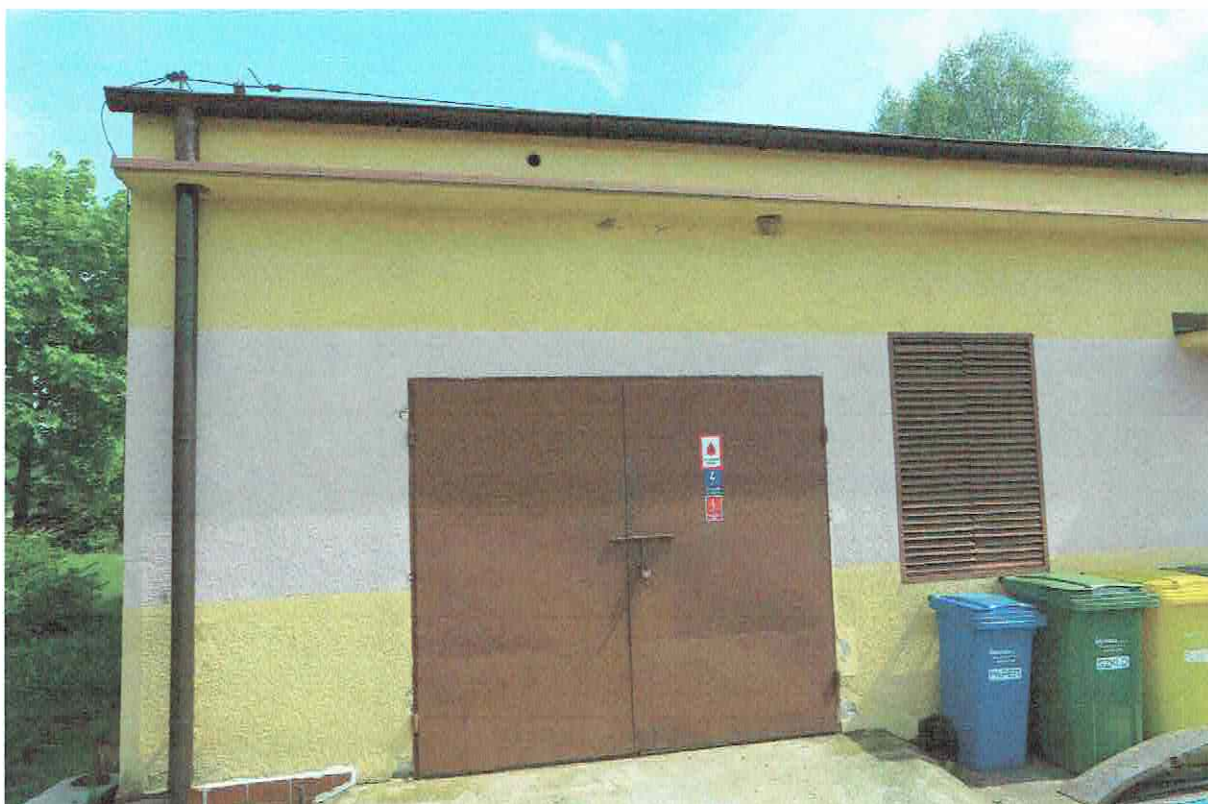
Fot. 4. Ogólny widok elewacji budynku.
