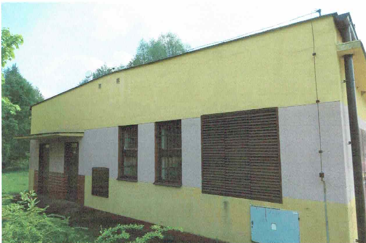
Fot. 1. Ogólny widok budynku.
