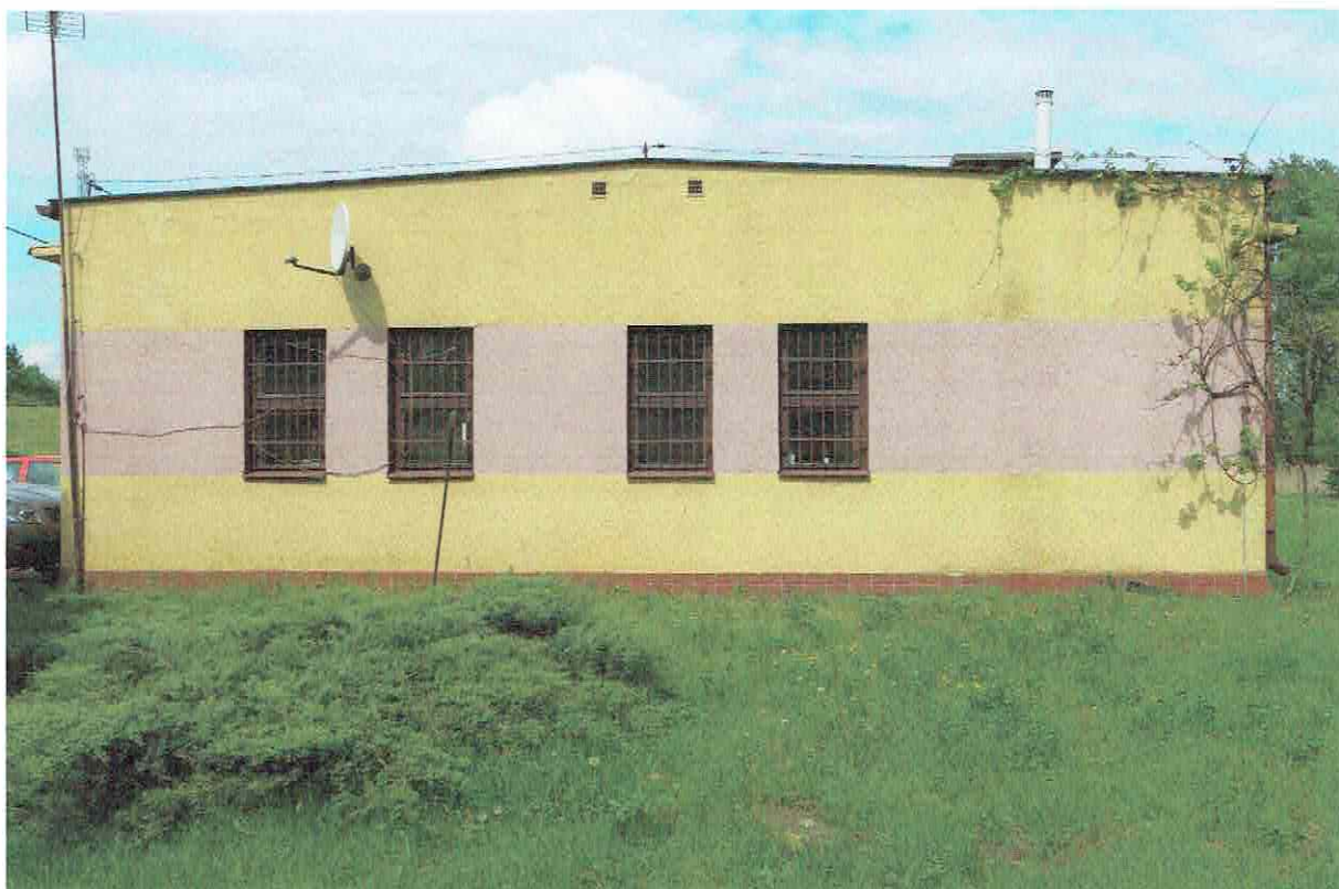
Fot. 2. Ogólny widok elewacji budynku.
