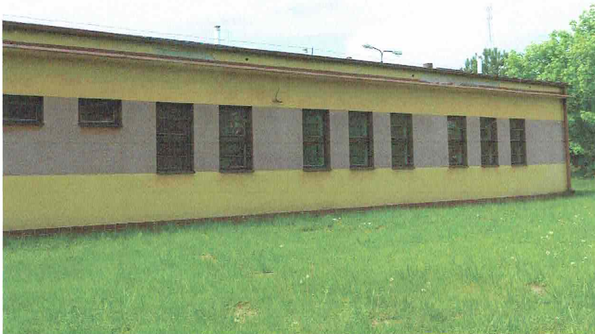
Fot. 3. Ogólny widok elewacji budynku.
