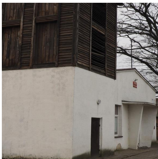
Zdjęcie 1. Remizo-świetlica w Chelmońcu i teren wokół
