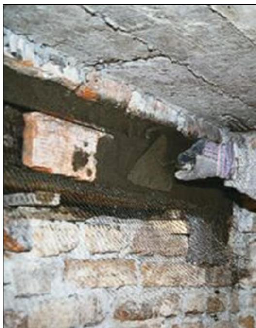
Belki stalowe wypełniono cegłą i obetonowano
