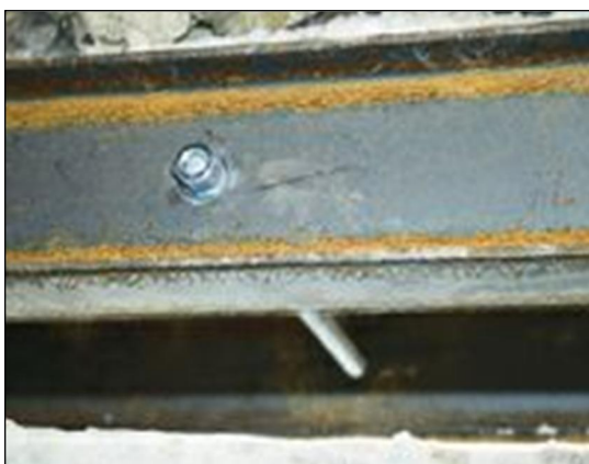
Połączenie skręcane belek stalowych nadproża
