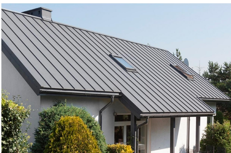
Przykładowy widok dachu krytego blachą na rąbek stojący
